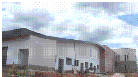
Andamento das obras da nova sede da Fermentec em Piracicaba
